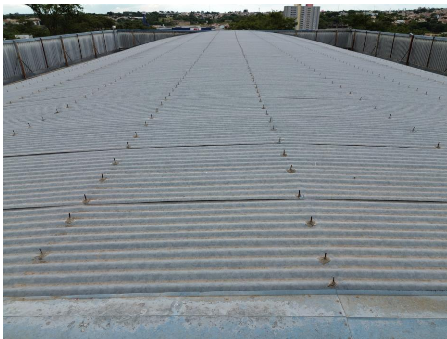
Imagem – Perspectiva do telhado do Ginásio de Esportes com detalhes dos parafusos das telhas
